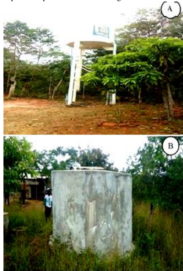
Figura 5 – Reservatórios de água na comunidade de Poções. A) Reservatório de metal com capacidade de 5.000 litros de água. B) Reservatório de alvenaria com capacidade para 19.000 litros de água.
