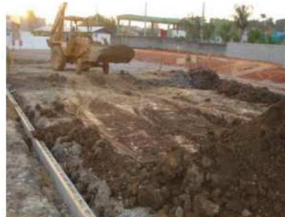
Figura 7: Utilizar sarrafo no topo, para garantir o nível e facilitar concretagem
