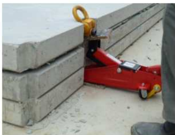
Figura 18: Macaco posicionado abaixo dos içadores
