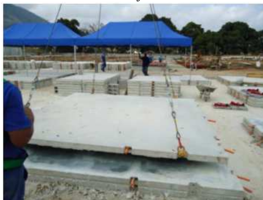
Figura 20: Utilização dos cabos de aço para içamento da laje
