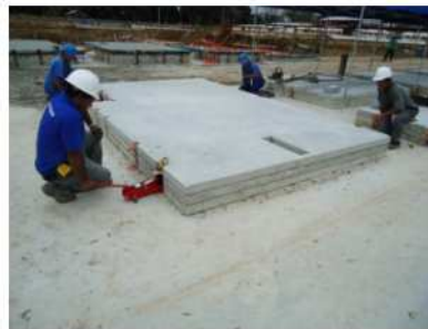
Figura 19 - Desplacamento realizado simultaneamente por macacos hidráulicos
