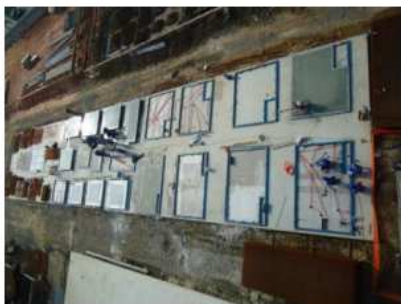
Figura 15 - Pista com algumas lajes prontas para receberem o concreto
