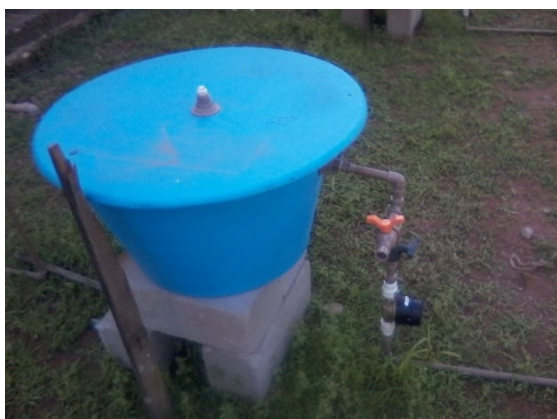
Figura 2. Biodigestor tampado Fonte: Marques (2014)
