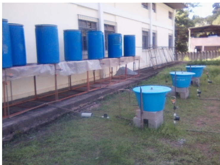
Figura 1 - Esquema dos recipientes interligados aos biodigestores. Fonte: Marques (2014)
