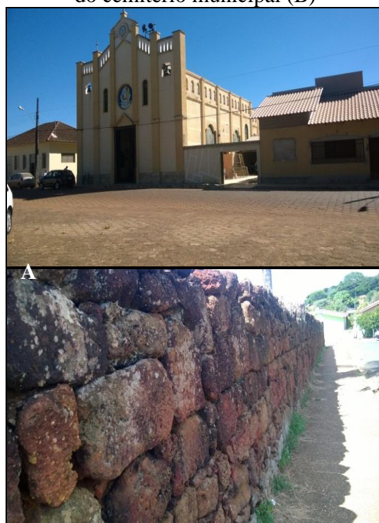
Figura 2: Bens materiais existentes em Santa Juliana: Igreja Matriz (A) e Muro do cemitério municipal (B)
