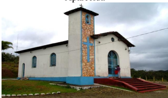
Figura 4 - Capela de Nossa Senhora Aparecida
