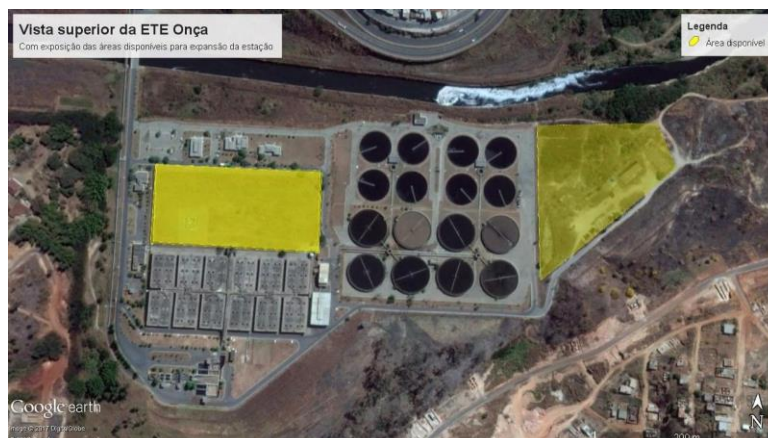
Figura 5- Vista superior da ETE Onça com exposição das áreas disponíveis para expansão da estação.
