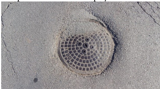
Figura 7 - Tampa parcialmente pavimentada de um poço de visita
