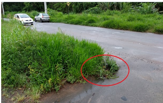
Figura 4 - Boca de lobo localizada na margem direita do ponto de cota mais baixa
