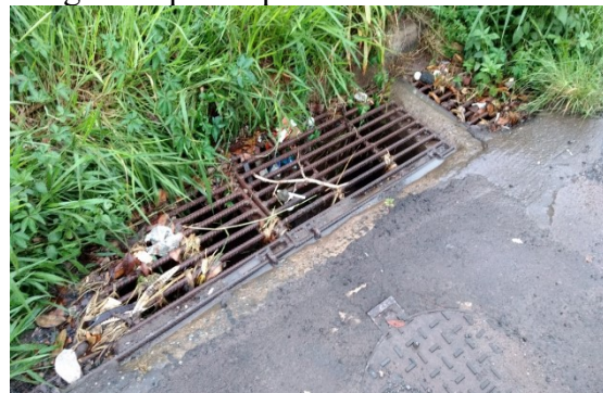
Figura 3 - Boca de lobo localizada na margem esquerda ponto de cota mais baixa
